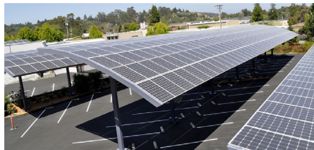
Figura 3 - Painéis fotovoltaicos aliados à arquitetura em coberturas de estacionamentos.
